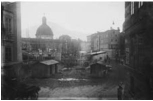
DIE ABRISSARBEITEN FÜR DEN NEUBAU DES POSTHOF'S IN DER KAIGASSE DEMOLITION WORK FOR THE NEW BUILDING OF THE POSTHOF ON KAIGASSE
