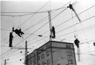
FAHRLEITUNGSREVISION DER ÖSTERREICHISCHEN BUNDESBAHNEN AM SALZBURGER HAUPTBAHNHOF IM MÄRZ 1966 REVISION OF THE OVERHEAD LINE OF THE AUSTRIAN RAILWAYS AT SALZBURG MAIN STATION IN MARCH 1966
