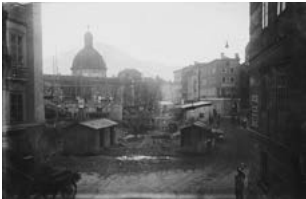
DIE ABRISSARBEITEN FÜR DEN NEUBAU DES POSTHOF'S IN DER KAIGASSE DEMOLITION WORK FOR THE NEW BUILDING OF THE POSTHOF ON KAIGASSE
