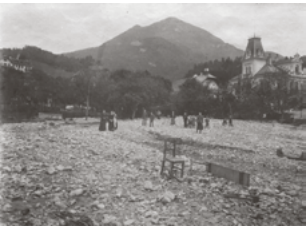
AUFRÄUMARBEITEN IN SALZBURG PARSCH NACH DEM HOCHWASSER VON 1897 ODER 1899 CLEARING-UP WORK IN SALZBURG-PARSCH AFTER THE FLOODS OF 1897 OR 1899
