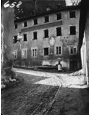
ABBRUCH VON MICHAEL HAYDNS WOHNHAUS AN DER FESTUNGSGASSE DEMOLITION OF MICHAEL HAYDN'S HOUSE ON FESTUNGSGASSE
