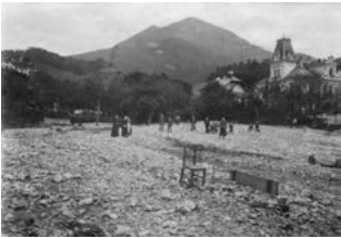
AUFRÄUMARBEITEN IN SALZBURG PARSCH NACH DEM HOCHWASSER VON 1897 ODER 1899 CLEARING-UP WORK IN SALZBURG-PARSCH AFTER THE FLOODS OF 1897 OR 1899
